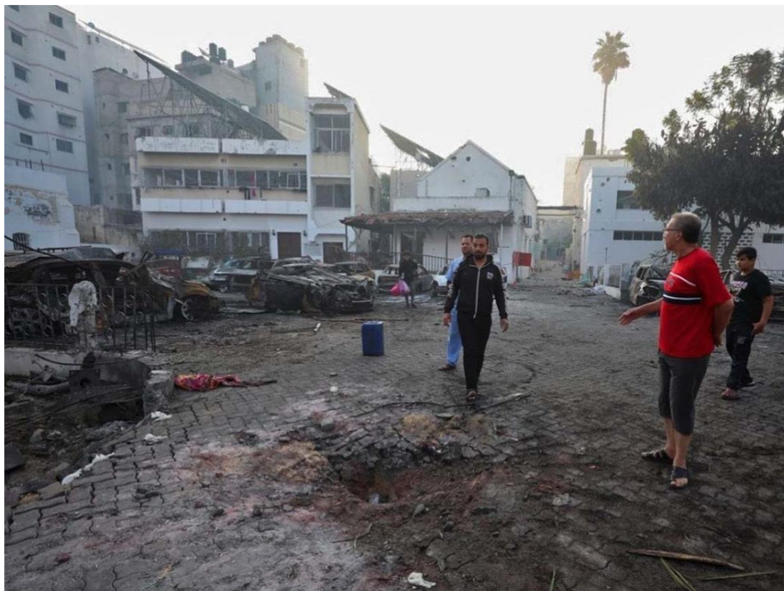
FIGURA 2: Buraco supostamente resultante do impacto do artefato explosivo.
